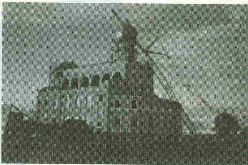
Nowo budowany kościół w Krasnojarsku
