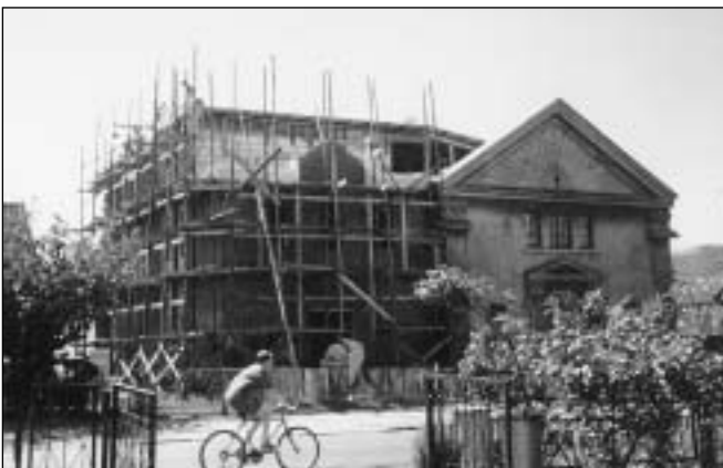
Kaplica w trakcie rozbudowy...
